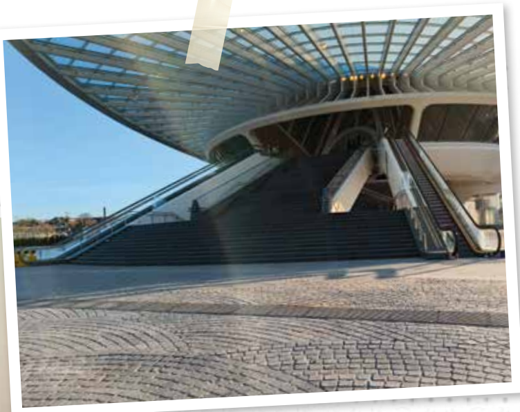
Les ascenseurs peu visibles depuis l'arrière de la gare, côté palais des congrès
