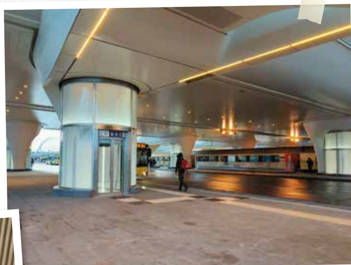
Les quatre ascenseurs en fonction depuis la place Léopold
